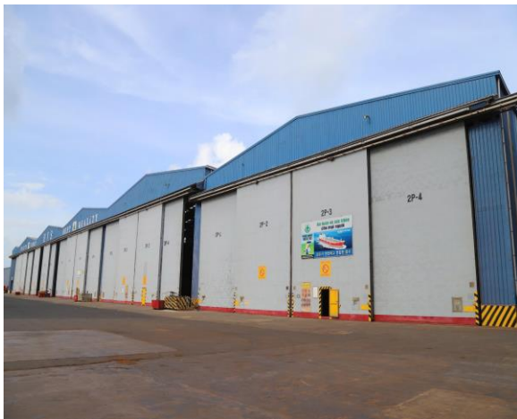
Hình 1.6. Xưởng sơn kín của nhà máy
